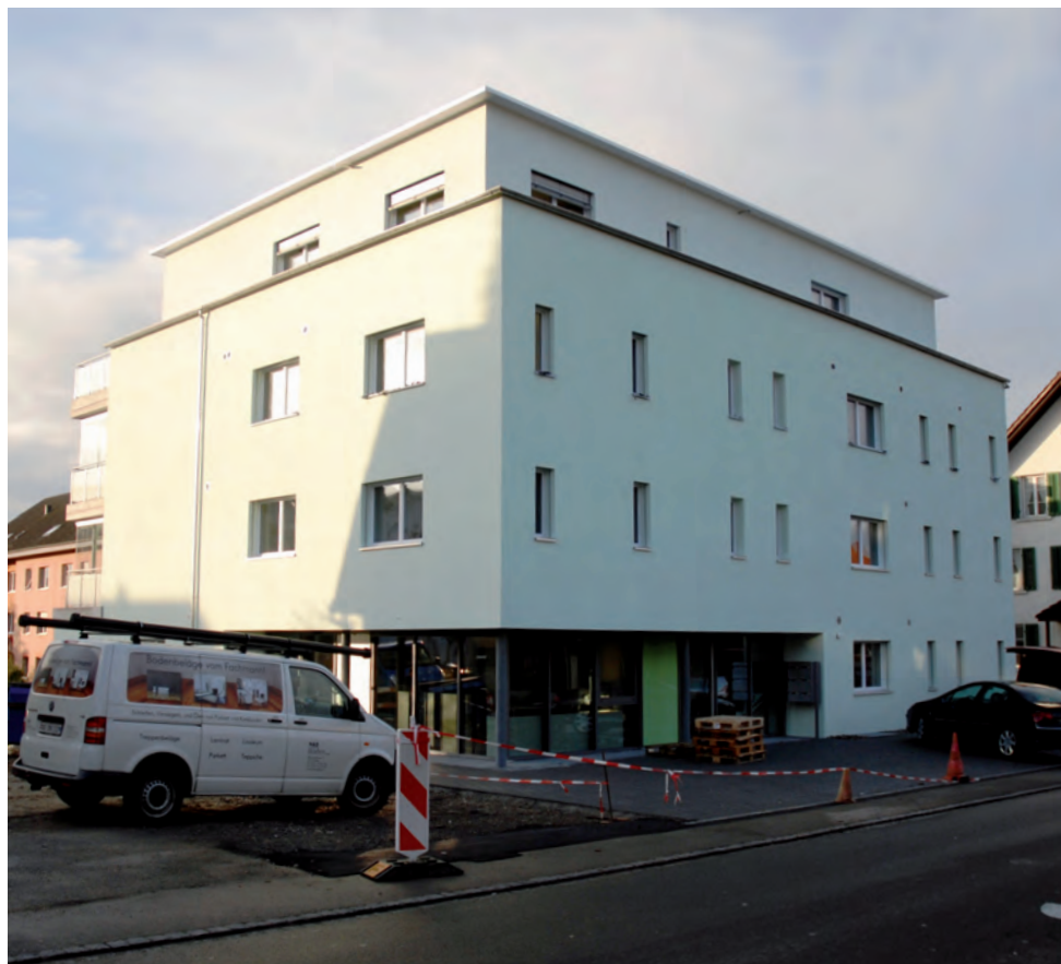
Der Neubau an der Schönbühlstrasse 1b in Fislisbach während der Fertigstellung (Foto: Ernst Bannwart).
