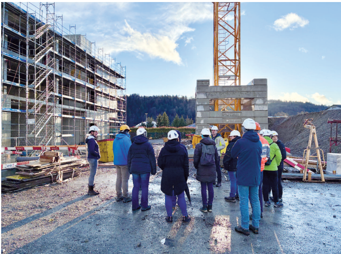
Mitarbeitende der SpiteX Heitersberg auf der Baustelle des neuen Stützpunkts vor dem entstehenden Neubau in Mellingen. Das Bild steht sinnbildlich für einen wichtigen Entwicklungsschritt, für starken Zusammenhalt und für das gemeinsame Engagement für eine gute und zukunftsorientierte Versorgung in der Region.
